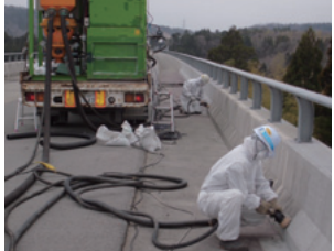
2人同時作業(橋梁高欄部の処理)
